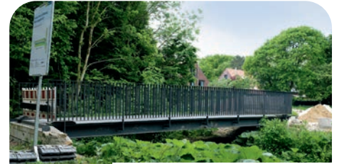
Brücke über den Gievenbach
